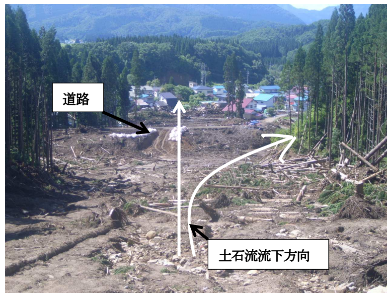
写真 5.10 氾濫域方向を望む
