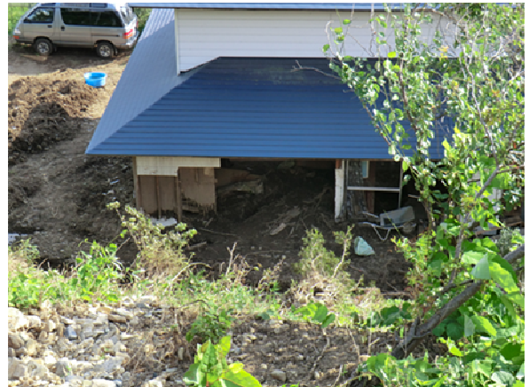
写真 4.2 家屋の裏手斜面の崩壊に伴い崩壊土砂が 1 階に流入。死者 1 名，家屋半壊。
