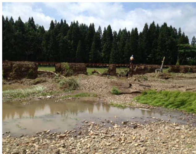
写真 5.16 串刺し状に流出した盛土
