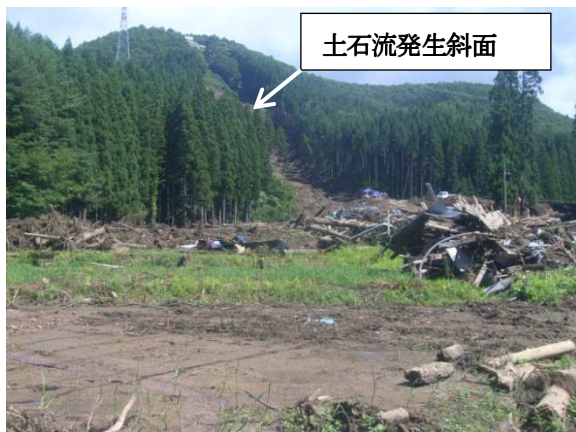
写真 5.2 氾濫域下流から土石流発生斜面を望む
