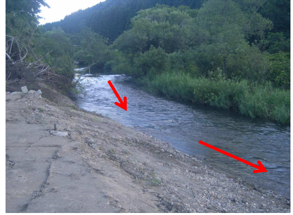
写真 5.46 緩い水衝部にあたる破堤箇所
