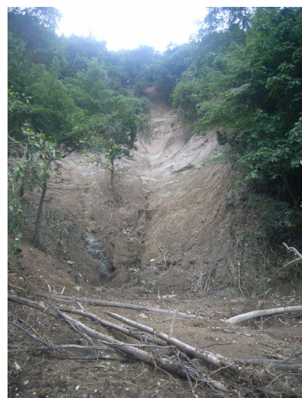
写真 4.28 岩盤を覆う表土類が崩壊し、岩盤が露頭する崩壊斜面
