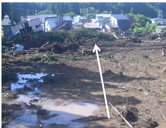
写真 5.11 道路を乗り越えて流下した方向の氾濫域 (手前が道路)
