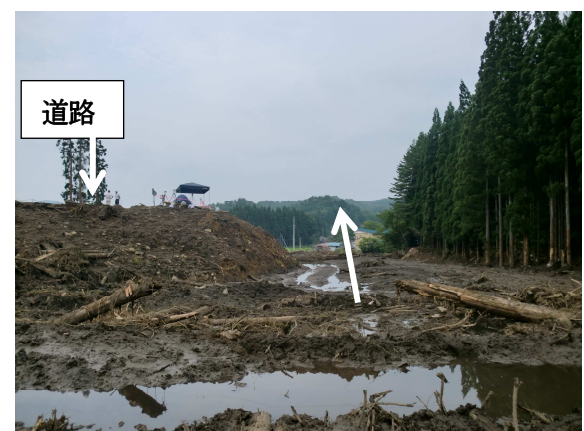
写真 5.14 同左 (上流より)
