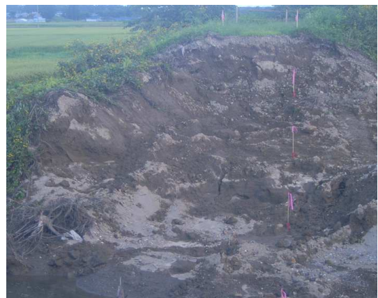
写真 5.48 砂質土からなる堤体材料
