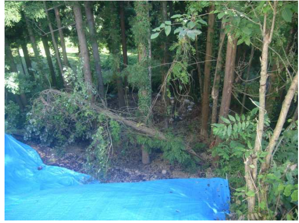
写真 5.42 斜面下部に堆積した崩壊土砂（土のうが混在する）
