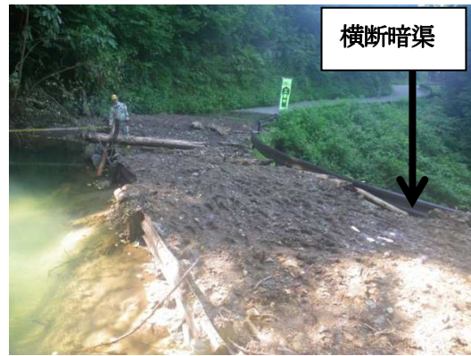
写真 5.33 暗渠の閉塞によるダムアップ状況
