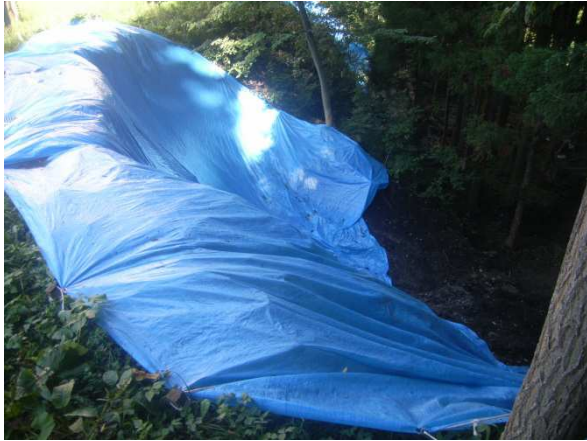
写真 5.41 幅 10m 弱，斜面長 10m 程度の表層崩壊
