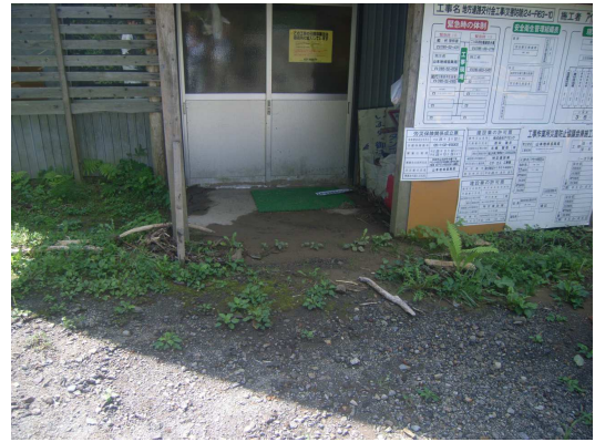
写真 5.25 道路を挟んで反対側にある現場事務所 (ドアの下部 20cm 程まで土砂が堆積)
