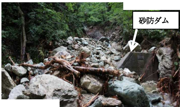
写真 5.28 道路わきの砂防ダムと沢を閉塞した土石流堆積物
