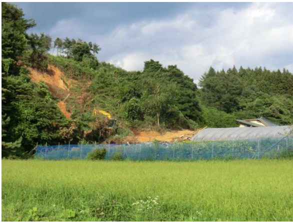
写真 4.5 斜面崩壊の側面方向からの全景。崩壊規模は斜面高さ約 20m, 崩壊幅約 30m。
