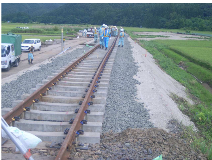
写真 5.19 復旧工事中の被災現場（写真 5.16 に対応：8 月 26 日撮影）。
