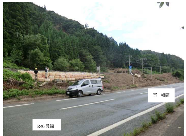
写真 4.25 流出土砂が延長約 200m 以上にわたり堆積。堆積土砂は細粒土砂が主体。
