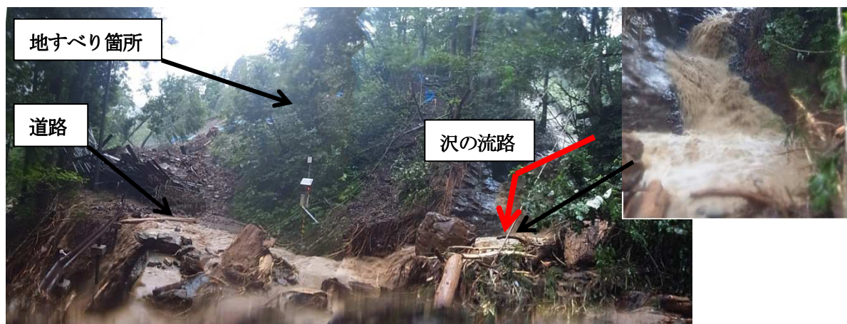
写真 5.35 側方（道路）より望む地すべり地と沢を流下する多量の表流水
