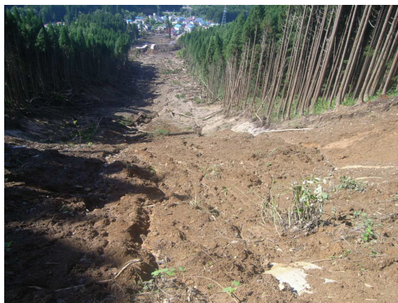
写真 5.9 崩壊域から下流方向を望む
