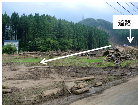
写真 5.13 道路にぶつかり流下した方向の氾濫域 (下流より)
