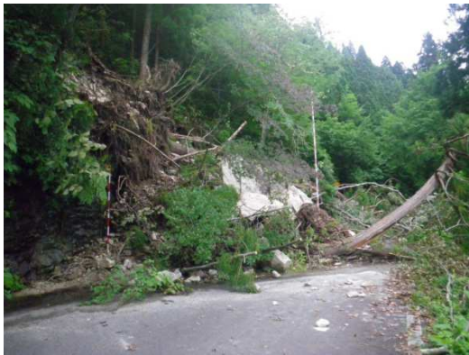
写真 5.20 道路上に崩落した土砂礫
