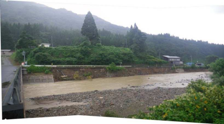
写真 5.36 被災箇所全景
