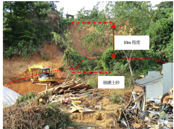
写真 4.6 崩壊斜面頭部の状況。崩壊土砂は黄褐色の粘性土からなる。末端部には厚さ約 2m で崩壊土砂が堆積し、崩土上の樹木が山側に 10 度程度傾斜している。
